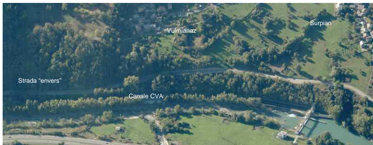
Foto 1: Panoramica del settore oggetto di intervento.
