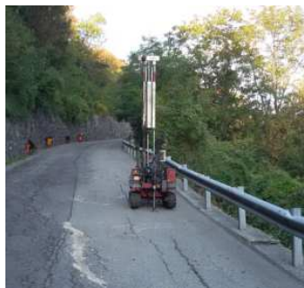
Foto 3: lavori di sondaggio in corrispondenza del cedimento della strada dell' envers .
