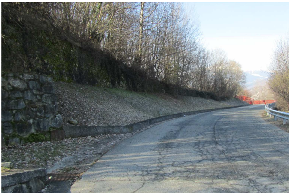
Foto 9: Muro di contenimento esistente
