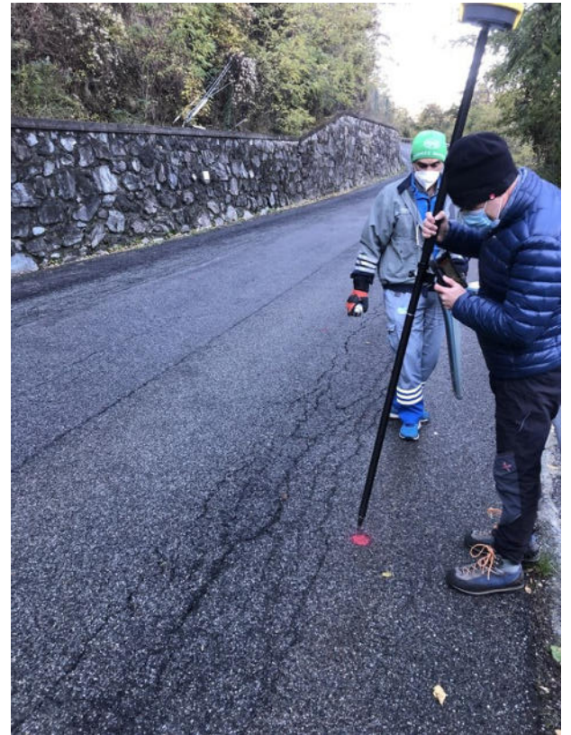
Tracciamento del metanodotto Perosa-Aosta per il posizionamento delle prove DPSH (Novembre 2021)
