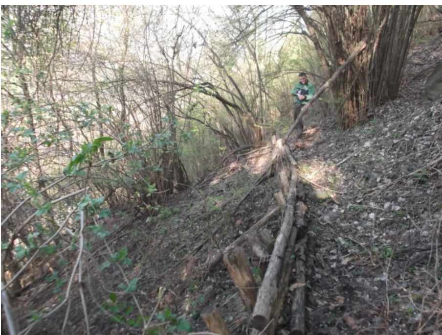
Foto 14: Particolare delle palificate in legno messe in opera lungo il tratto mediano del pendio a seguito dell'interrimento della condotta del metanodotto.
