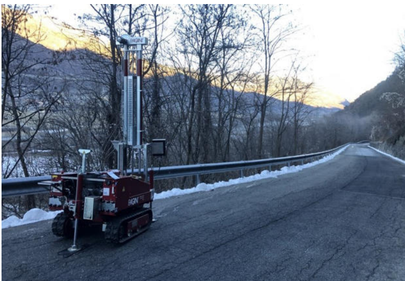
Particolare delle fasi esecutive delle prove DPSH lungo la carreggiata stradale (Gennaio 2021)
