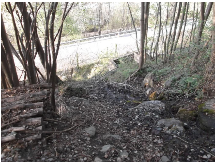
Foto 16: Vista del ruscello proveniente della frazione di Vuilmianaz e della vasca di raccolta ormai fuori uso posta poco a monte della strada dell'envers.
