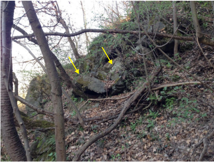
Foto 12: Nicchia di crollo recente poco a valle della situazione E. Si notano alcuni blocchi in precarie condizioni di stabilità.
