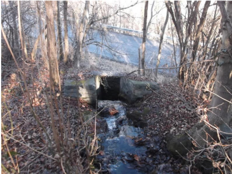
Foto 29-30: la conoide del T. de Vulmianaz presso la strada dell'envers. Si notino gli accumuli di spietramento lungo vecchi alvei e il pozzetto di imbocco dell'attraversamento.
