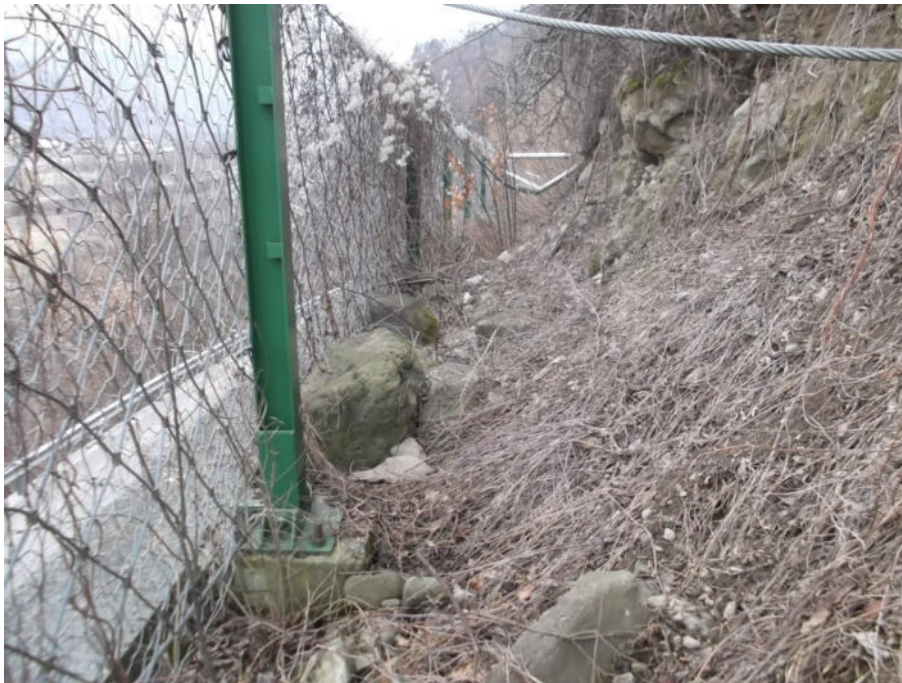
Foto 23: Particolare dei blocchi appoggiati alla barriera esistente provenienti dalla scarpata della situazione L
