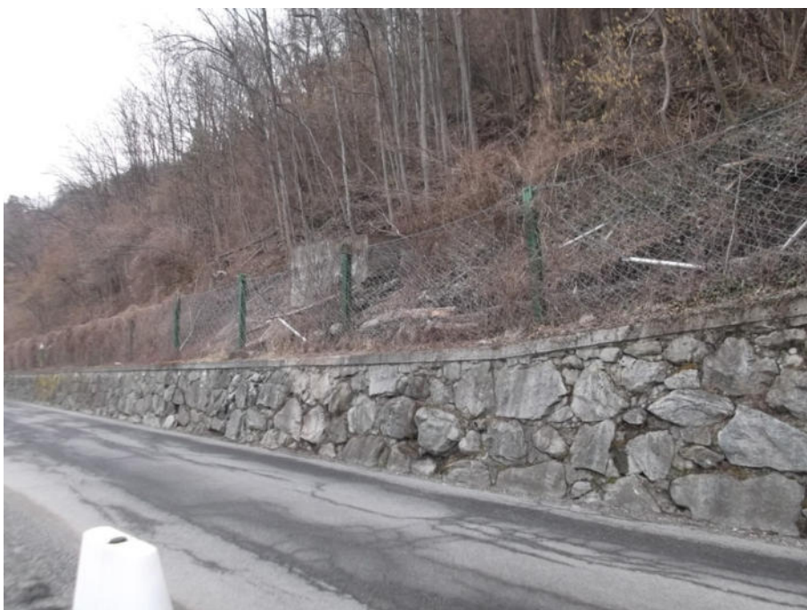
Foto 28: Panoramica del muro di controripa della strada dell'envers e della barriera paramassi esistente in corrispondenza della situazione G.
