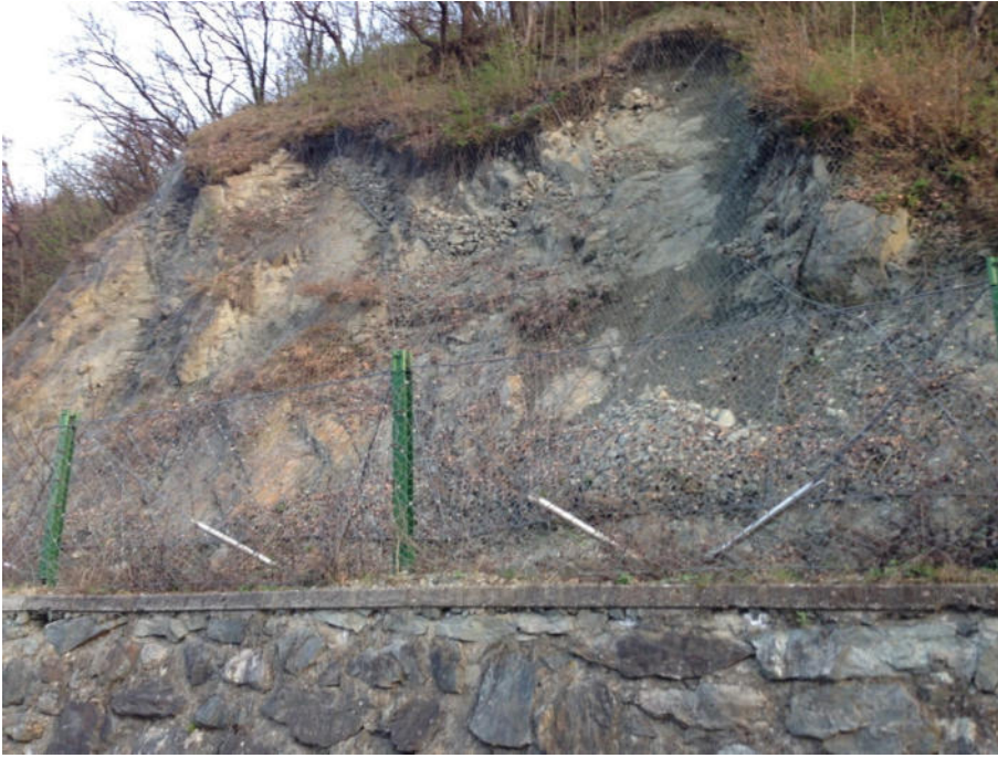
Foto 7: Vista della situazione di dissesto D, oggetto di sistemazione con posa di reti corticali. Si evidenzia l'esigenza di intervenire per alleggerire la rete corticale.
