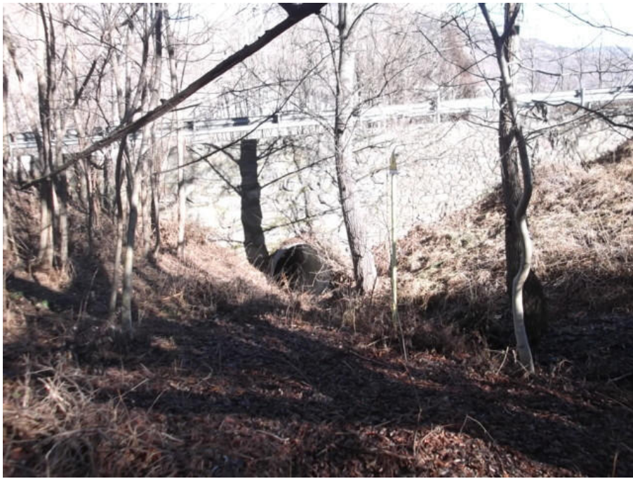
Foto 28: la tubazione (1200 mm) di attraversamento del rio che raccoglie le acque irrigue sul lato est di St. Marcel.
