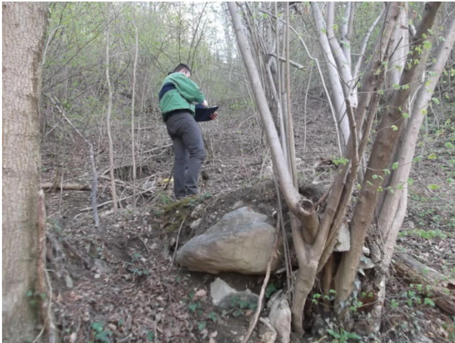
Foto 8: Particolare dei blocchi costituenti il deposito di frana posto al piede del pendio in corrispondenza dell'impluvio che delinea il margine orientale del lotto di interesse. Il fenomeno, con tutta probabilità riconducibile all'alluvione del 2000, è caratterizzato da un piccolo evento di colamento rapido innescatosi poco a monte della SR.
