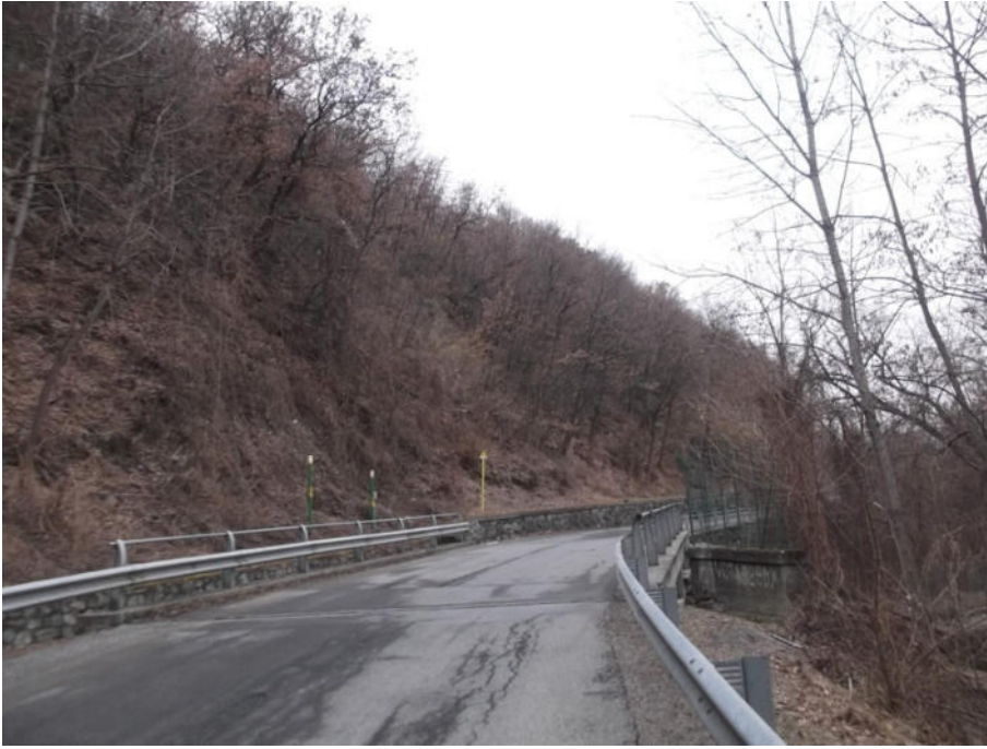
Foto 1: Vista dell'estremità E del lotto, in corrispondenza del ponte sul canale CVA.
