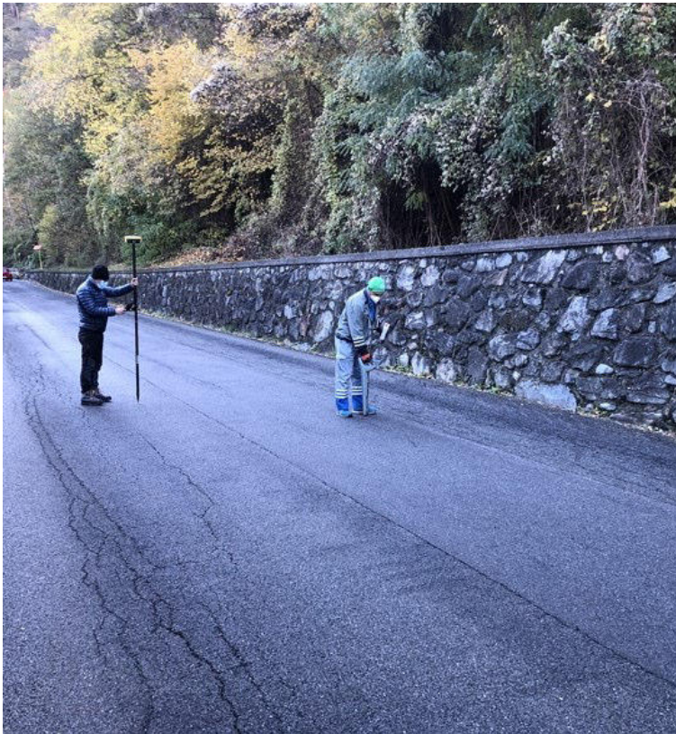
Tracciamento del metanodotto Perosa-Aosta per il posizionamento delle prove DPSH (Novembre 2021)
