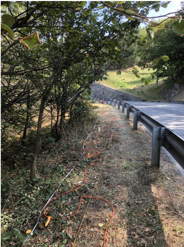
Fasi esecutive dell'indagine sismica a rifrazione (Ottobre-Novembre 2021)
