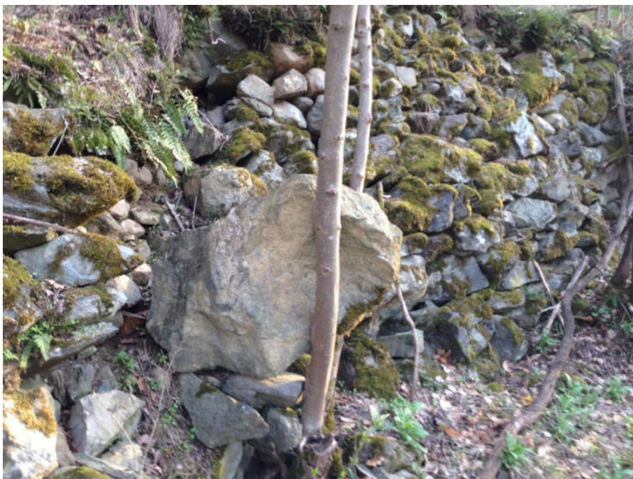
Foto 27: Particolare di alcuni blocchi altamente instabili al piede del terrazzamento agricolo della situazione N.
