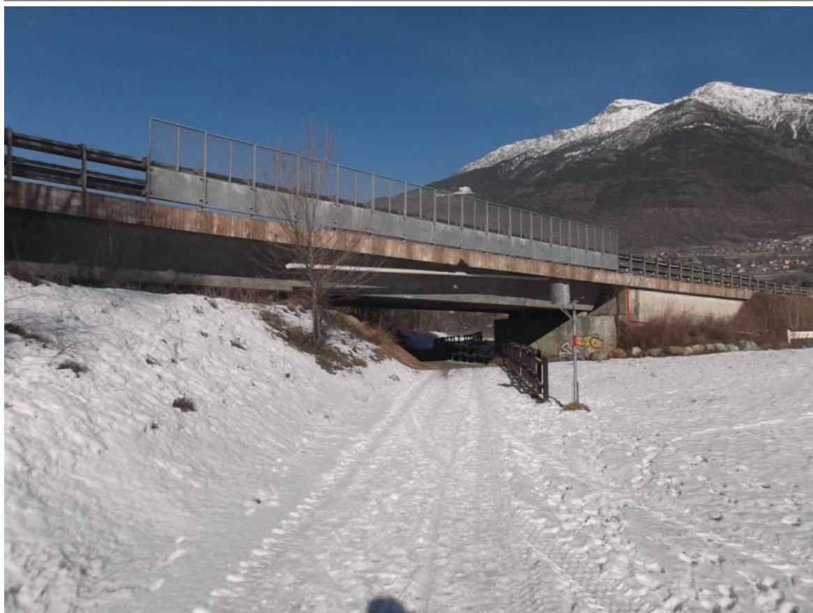
FOTO 2 : panoramica da monte del sottopasso e della pista ciclabile che lo attraversa, fiancheggiata dalla pista sterrata.
