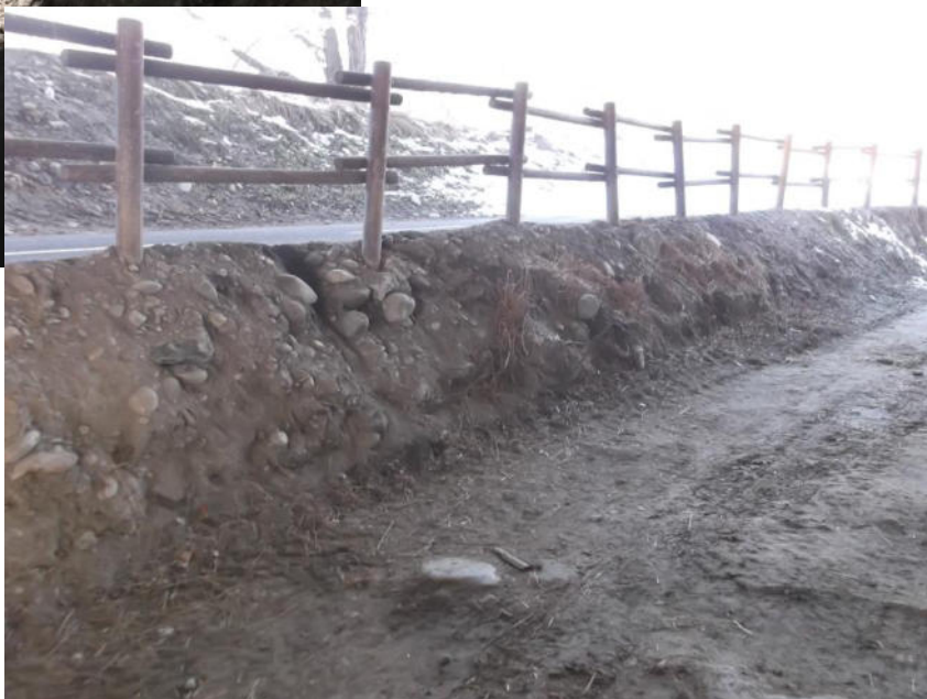
FOTO 4-5: particolari della scarpata in materiale alluvionale che separa la pista ciclabile dalla strada agricola sterrata.
